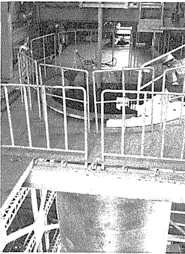
高さ二十五メートルの燃料取扱機器試験装置の頂部
