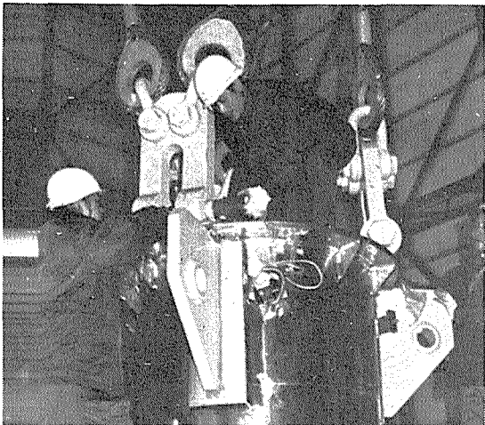
燃料交換用キヤスクの解体作業
