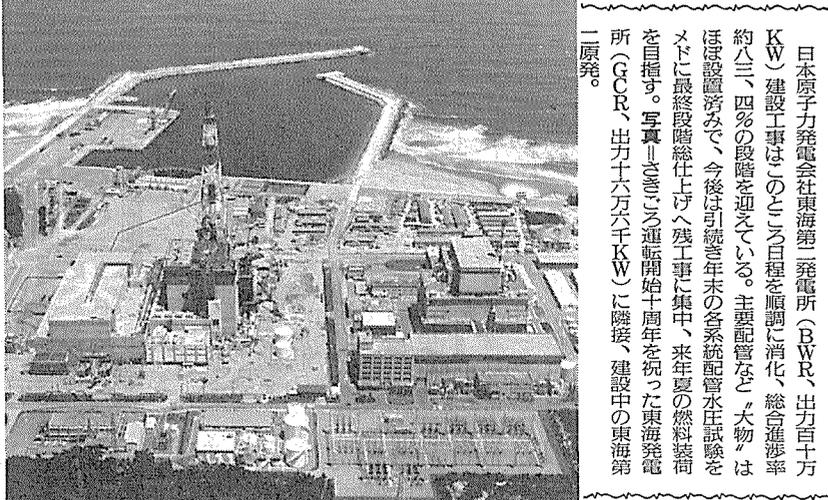
日本原子力発電株式会社東海第二発電所(2000MW)出力百十KW)建設工事はこのところ順調に進捗、総合進捗率約八三、四の段階を迎えている。主要配管などほぼ設置済みで、今後は引続き年末の各系統配管水圧試験をメドに最終段階仕上げへ残工事に集中、来年夏の燃料装荷を目指す。写真上向きは通電開始十周年を祝った東海第二所(GCR、出力十六万六千KW)に隣接、建設中の東海第二原発。
