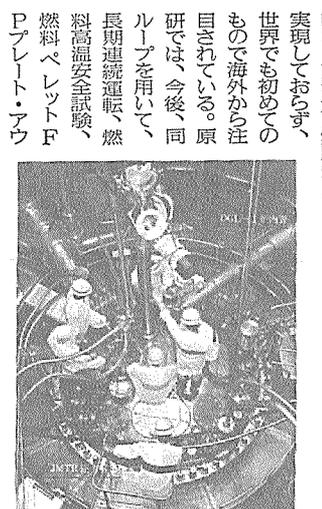
OG-LIは、多目的高温ガス炉内に使われる燃料・材料などを冷却し、冷却材ヘリウム入口温度
