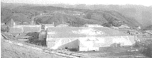
遠心機据付けが始まった濃縮プラント（入形峠）
