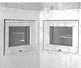
放射線廃棄物ドラム詰室視窓
