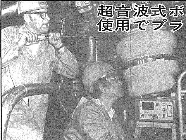
米国ではすでに航空機やロケットはもちろん原発プラントの重要配管、機器締付ボルトやRPV据付ボルト等の軸力設定に Raymond Engineering Inc 製 EXTENSOMETER が使用されております。誤差の大きい従来のトルク管理方式に代り、精度の高い EXTENSOMETER による超音波軸力測定方式の採用が原子力業界で急速に広まりつつあります。
