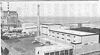
完成した燃料試験施設
