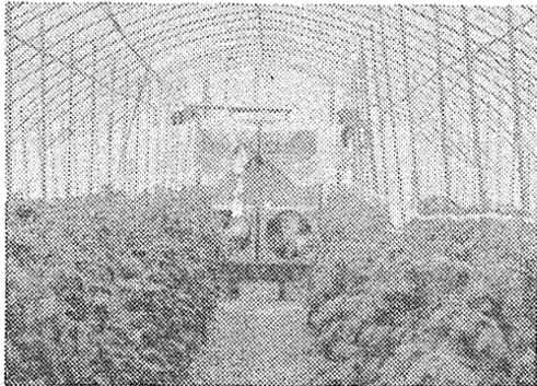
電力中央研究所は、このほど原子力発電所から放出される温排水を温室の暖房用に使うための小型、高性能の熱交換器の開発に成功した。
