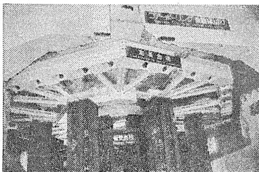
日本原子力研究所は、茨城県東海村の老朽化した研究炉JRR-3（重水減速重水冷却炉、熱出力一万kW）を、さっさとそのまま床から切り離し、隣接の大型廃棄物保管庫へ移送・廃棄する「一括搬出工法」の作業をすべて終了した。約二千二百五十トンの炉体を四層吊り上げ、水平に三十四層移動し、十層降ろす大作業だった。原子力分野ではめずらしい廃止措置の方法を、写真で追ってみた。
