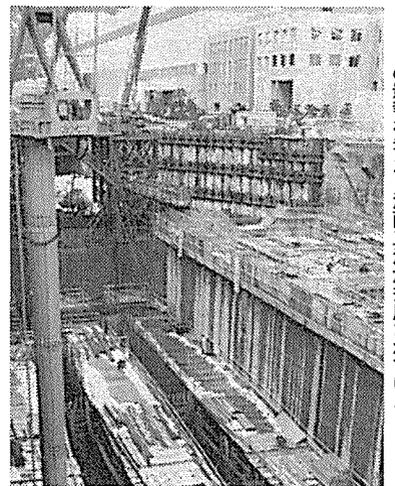
循環水ポンプ室の基礎工事には既設発電所への影響を考え、潜函工法が採用されている
