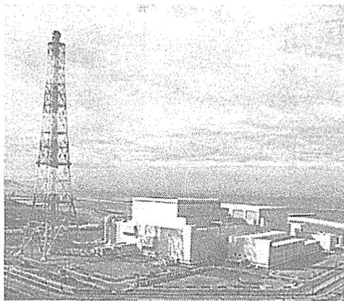
▶ 2号機タービン建屋、3台のタービンと1台の発電機が百十万KWのパワーを生み出す。
