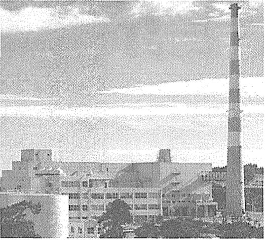
高レベル廃棄物は現在、東海処理工場内に液体の形で貯蔵されているが、将来はガラス固化して地層処分される
