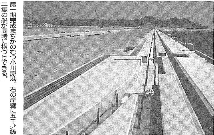
第一期完成まじかのむつ小川原港。右の岸壁に五千ト級二隻の船が同時に横付けできる。
