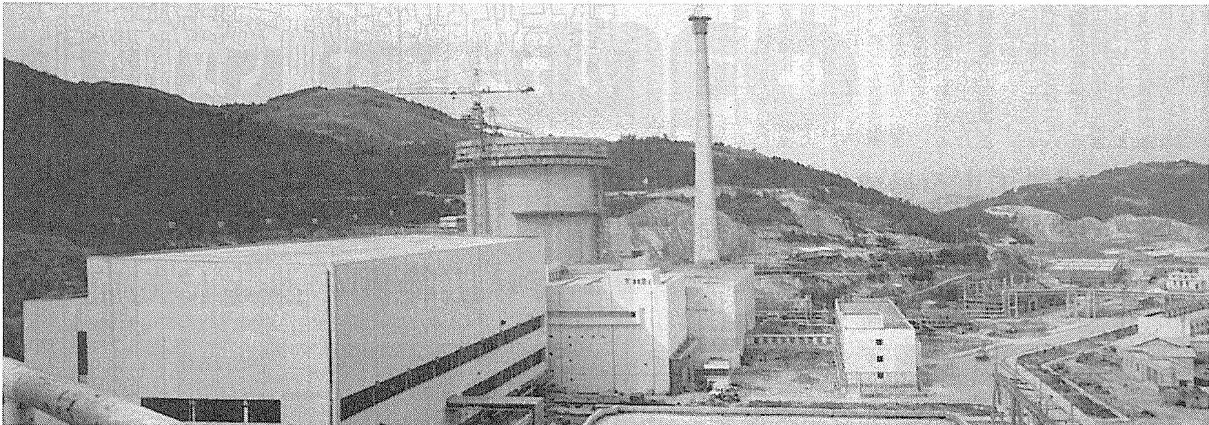
秦山原子力発電所の全景(中央の円筒が原子炉建屋、左手前がタービン建屋、中央手前が中央制御室が入っている建物、煙突の前が補機建屋)
