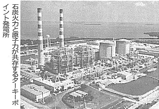
石炭火力と原子力が共存するターキーポイント発電所
