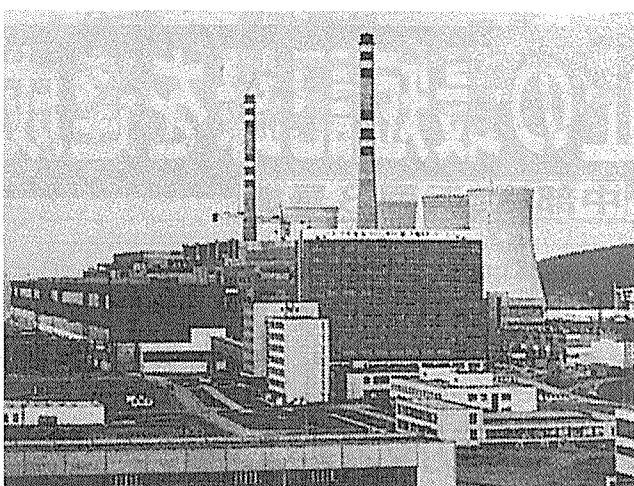
建設中のモホフチエ原子力発電所
