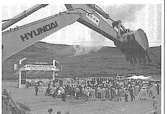
写真は去年八月十九日に現地で行われた敷地造成工事。式典もあつた。
