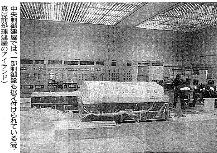
中央制御建屋では、一部制御盤も据え付けられている(写真は前処理建屋のアイランド)
