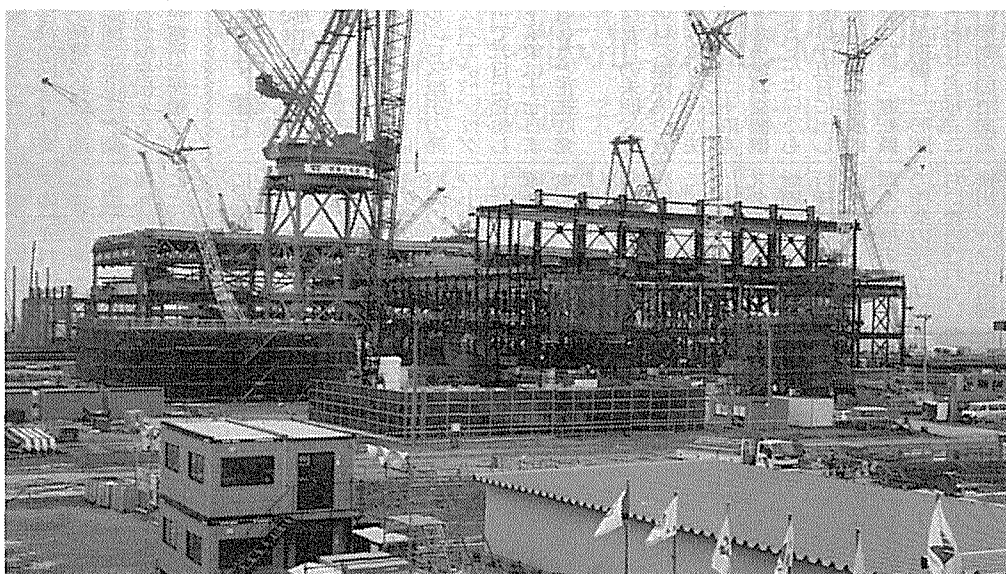
建設の進む東北電力・東通原子力発電所1号機 (写真手前：原子炉建屋 同奥：タービン建屋)
