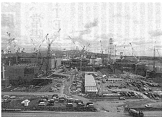
建設が最盛期をむかえている六ヶ所再処理施設。今年4月末時点で工事進捗率は約66%
