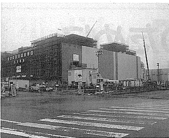
一部外壁が完成するなど、順調に建設の進む六ヶ所再処理工場
