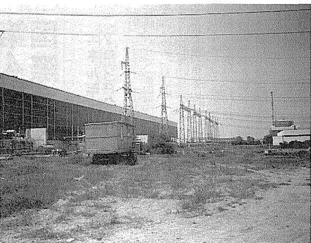
コスロドイ原発1・4号機のタービン建屋
