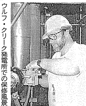
ウルフ・クリック発電所での保修風景
