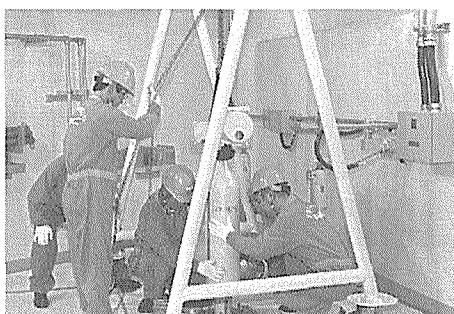
改造工事は一次主冷却系上部室のモーター取り付けで開始
