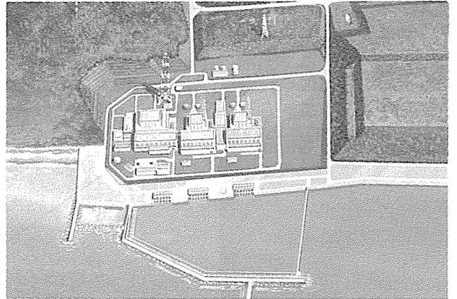
柏崎刈羽原子力発電所6,7号機完成予想図(右から)がコンパクト化され、耐震性および経済性が向上している。改良型制御棒駆動機構の採用により、水圧駆動に加え、電動駆動方式が追加され、制御棒駆動源が多様化されている。また、鉄筋コンクリート製格納容器の採用により原子炉建屋がコンパクト化され、耐震性の向上が図られている。この結果、改良型BWRは電気出力が135万6,000kWと増強されているにもかかわらず、その建設単価は従来の110万kW級に比べ20%低減されている。
