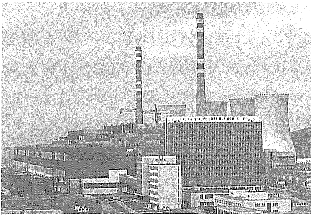
スロバキアで建設中のモホフチェ発電所。
