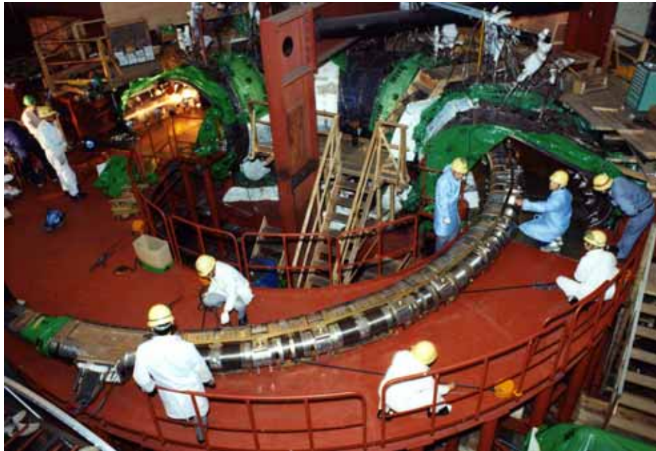
図 4.1.2-1 磁気リミタコイルの JT-60 真空容器への組み込み
