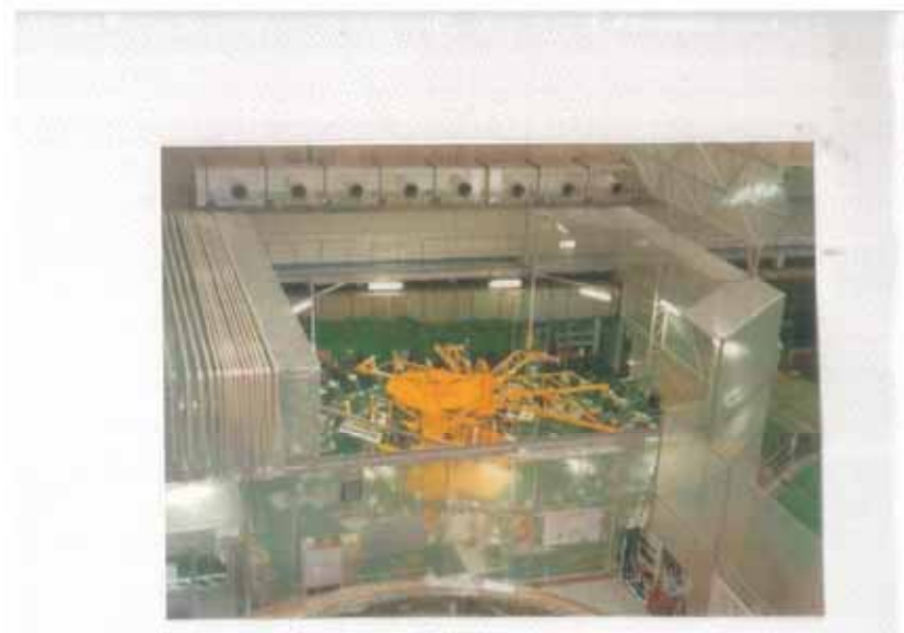
図 4.1.3.2-1 0V コイルの現地製作状況(LHD 本体室内に防塵フードを仮設)
