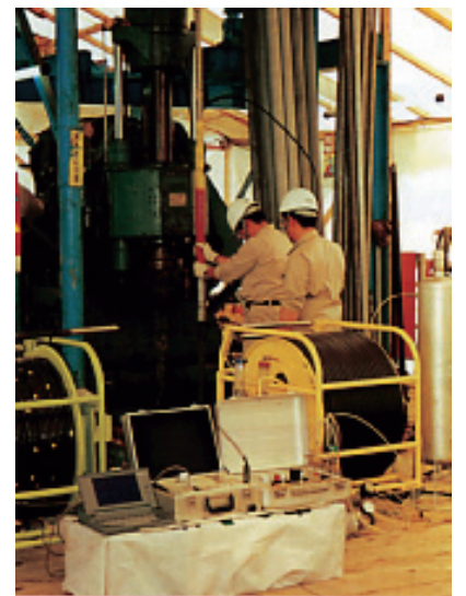
ボーリング調査の様子(地盤に実際に孔を掘り、地下環境を調べます)
