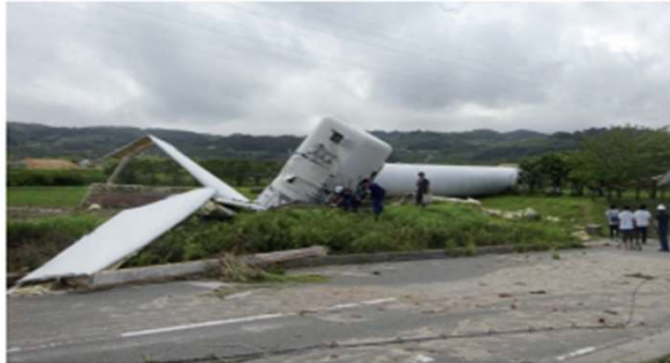
兵庫県淡路市風力発電設備倒壊 (2018年8月台風)
