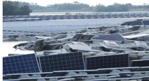
千葉県市原市水上設置型太陽光発電所損壊 (2019年9月台風)
