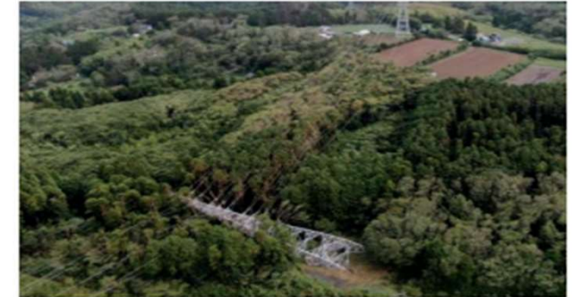
千葉県君津市送電線鉄塔倒壊 (2019年9月台風)
